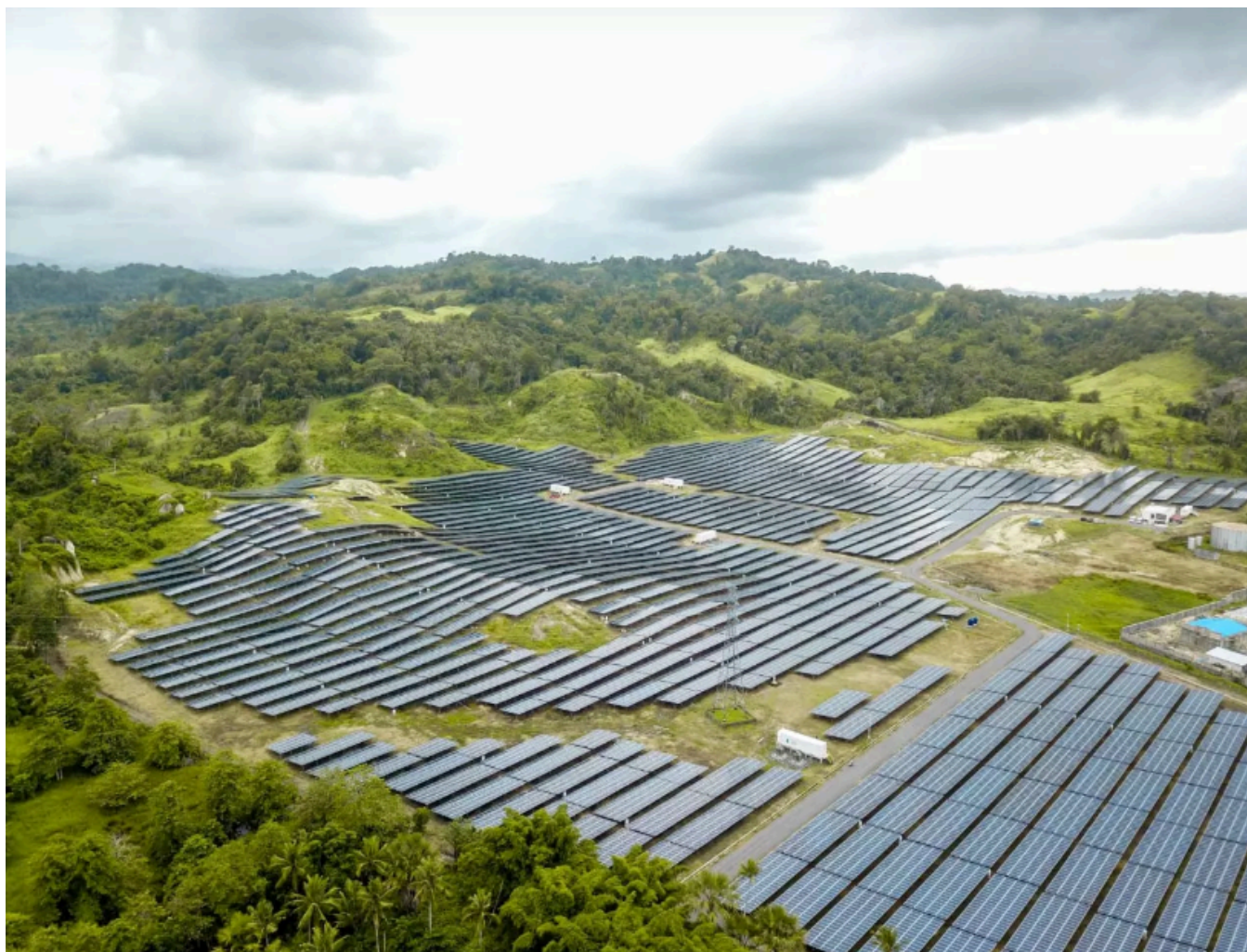
Panel Surya di Minahasa, Sulut. (Foto: Kementerian ESDM)
